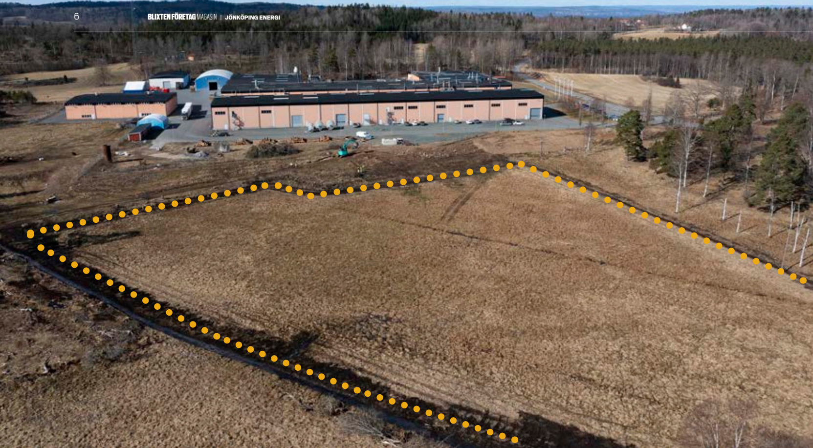
Ytan där 2 050 solpaneler ska monteras är ungefär i storlek av två fotbollsplaner och ligger i direkt anslutning till fabriken.
